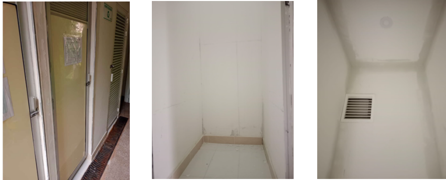
Cuarto de residuos
